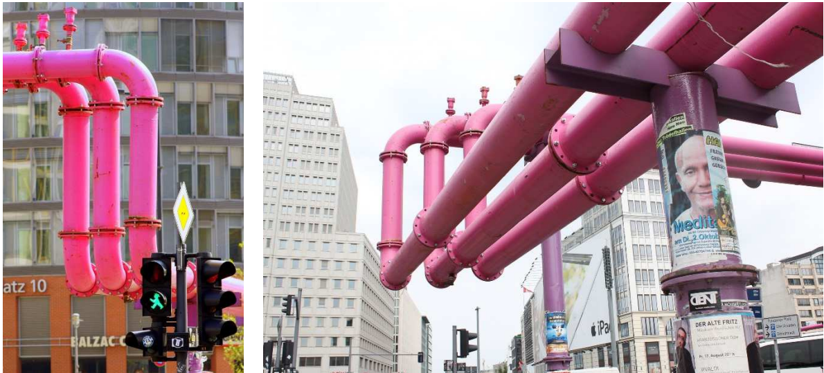
Figur 30 Luftburna ledningar i Berlin som leder bort grundvatten till recipient. Bild till vänster från (Bild från webbplats, 2018) bild till höger från (Bild på luftburna ledningar i Berlin, 2018)
