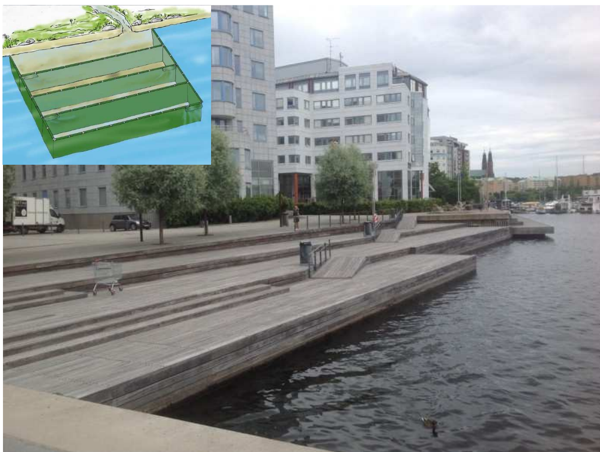
Figur 31. Exempel på skärbassäng under ett trädäck (Foto: Järven Ecotech)
